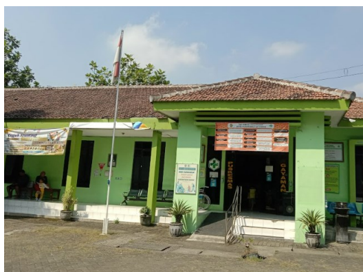
Gambar 4.19. Dokumentasi Puskesmas Gayaman tidak memiliki fasilitas guiding block untuk jalur akses disabilitas.
