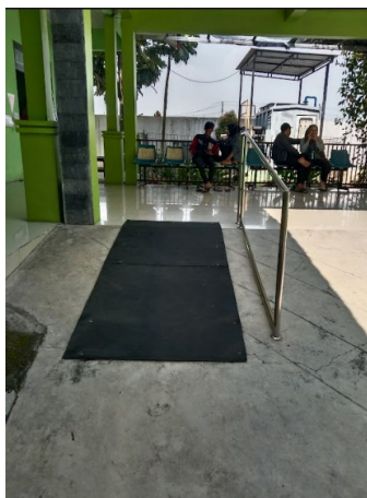
Gambar 4.53. Dokumentasi terdapat handrail pada jalur disabilitas Puskesmas Gayaman
